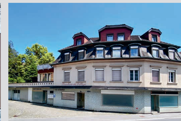
Horw (LU) Wohn- und Geschäftshaus
