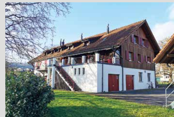
Schlatt (TG) Mehrfamilienhaus mit zusätzlicher Baulandreserve
