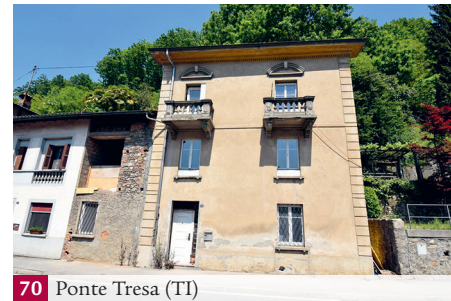
70 Ponte Tresa (TI)
