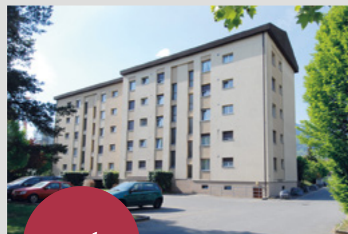
Monthey (VS) Immeubles locatifs
